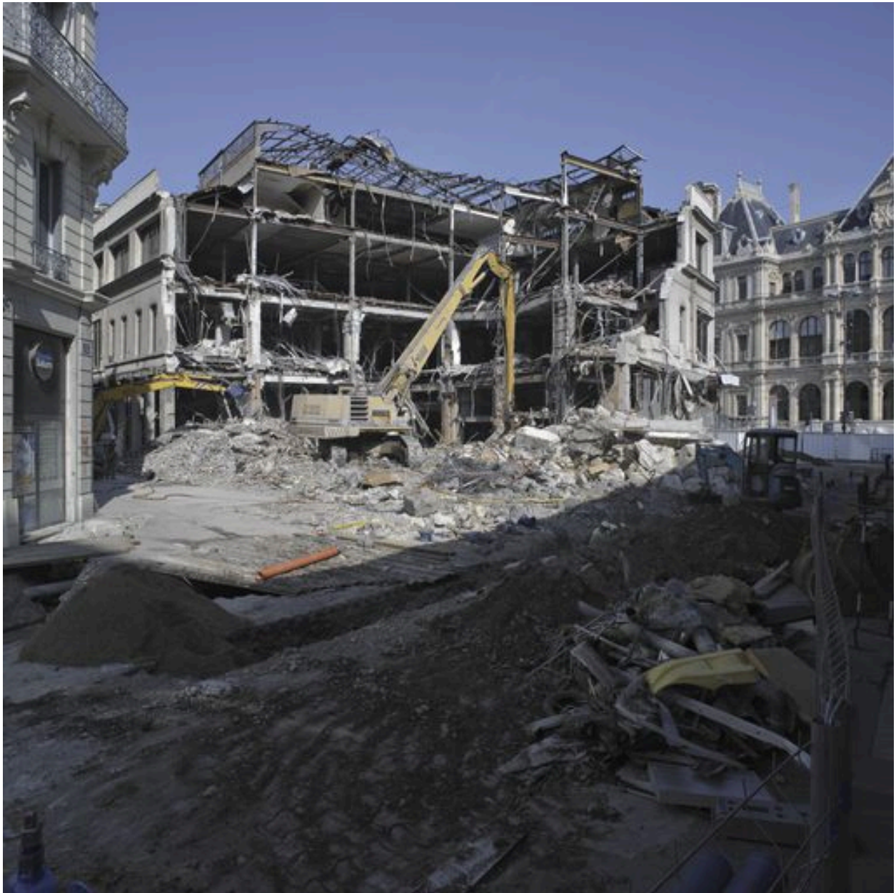
La démolition du Grand Bazar, août 2005
