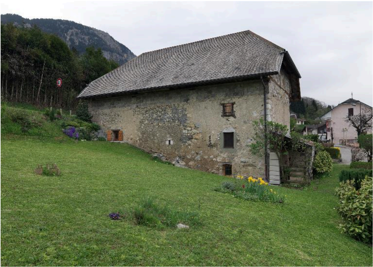
Vue d'ensemble de la façade arrière de la ferme.
