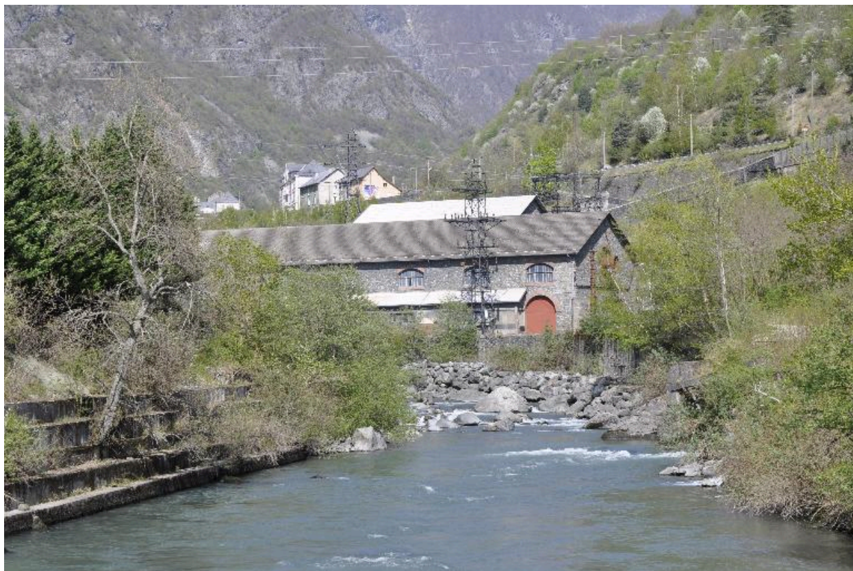
Vue de la centrale
