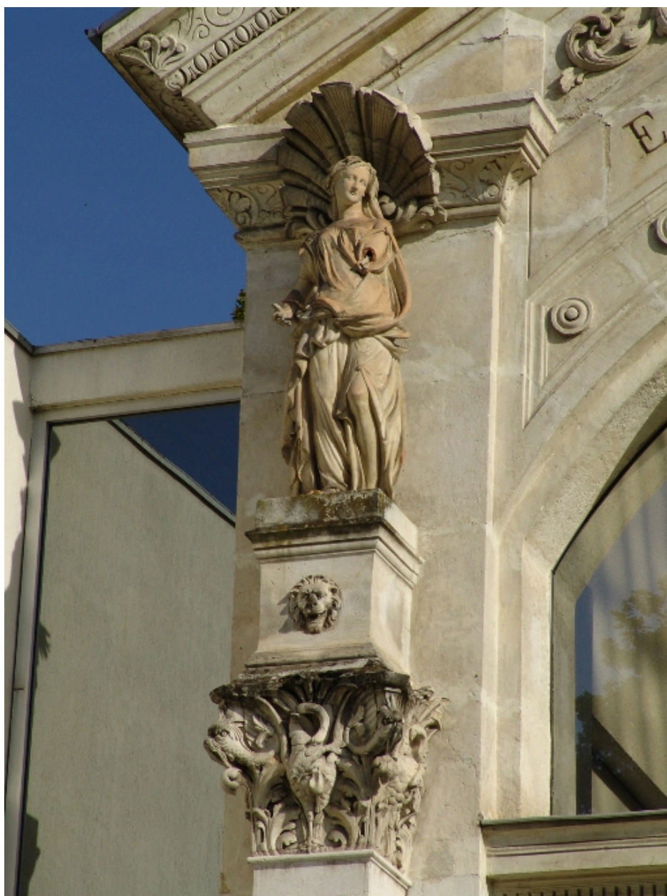
Détail : décor gauche de la façade
