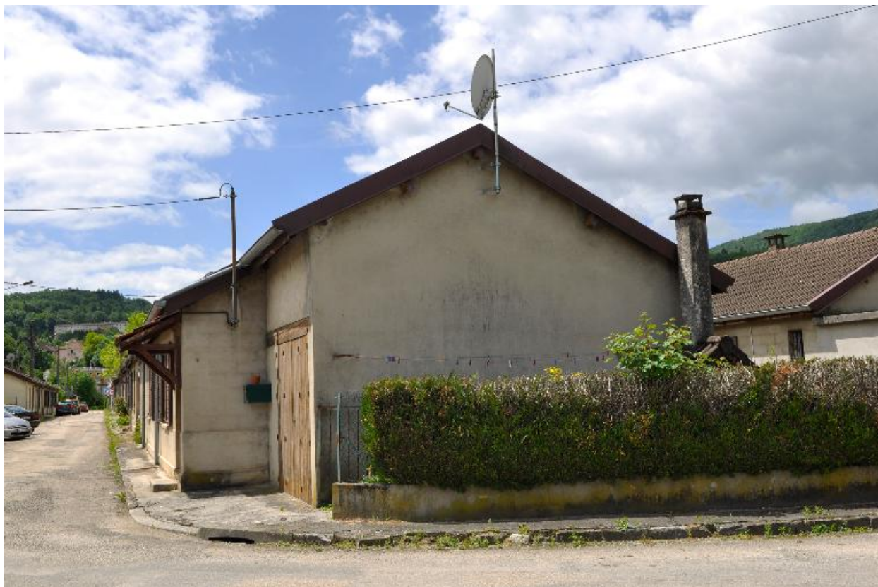
Pignon et alignement des baraquements
