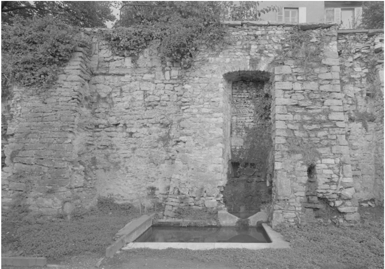
Mur de soutènement de la terrasse, détail, et source (parcelle AD 256).
