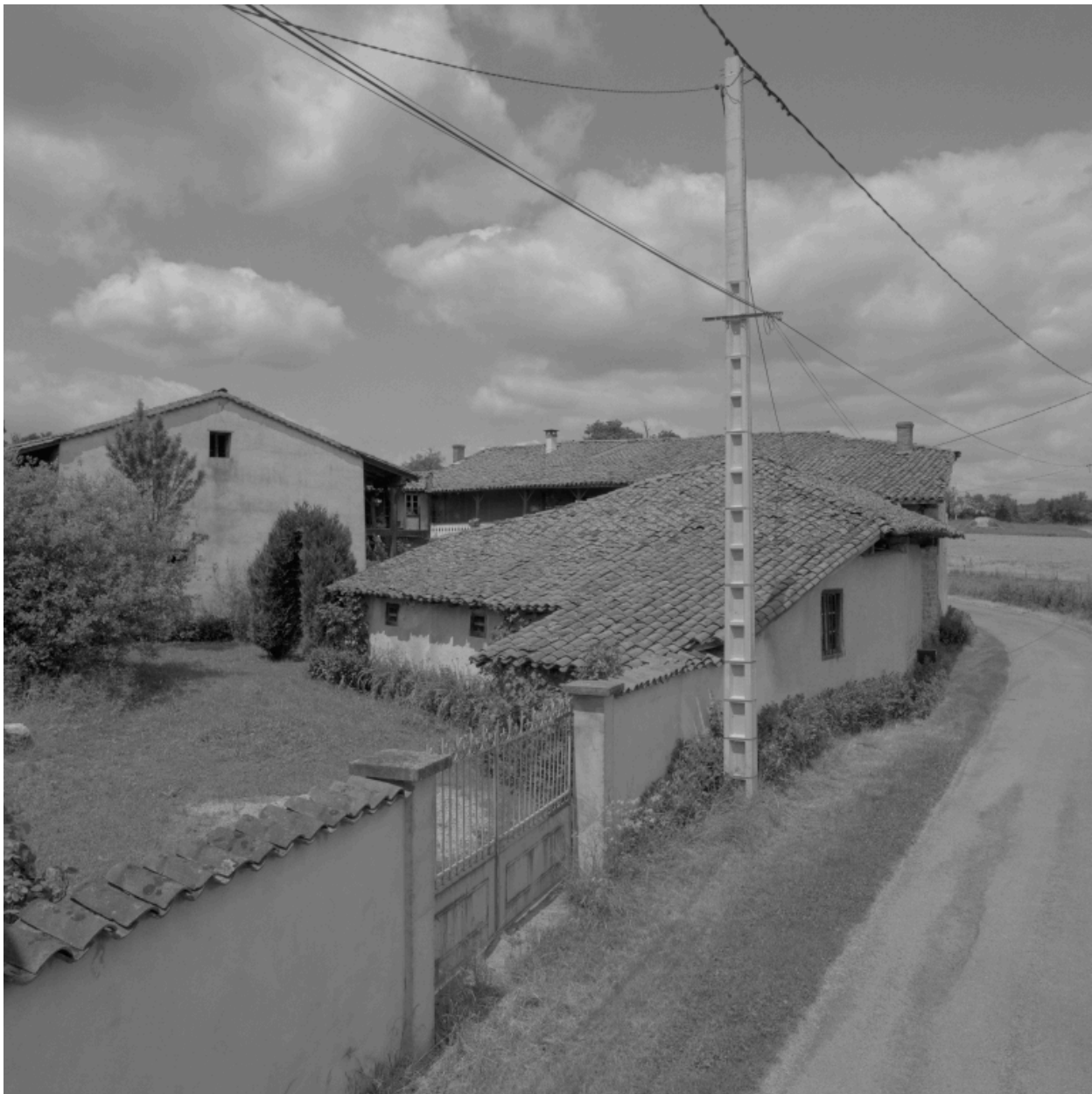
Saint-Sixte, Jay (1987 A3 880). Vue d'ensemble des bâtiments depuis le sud.
