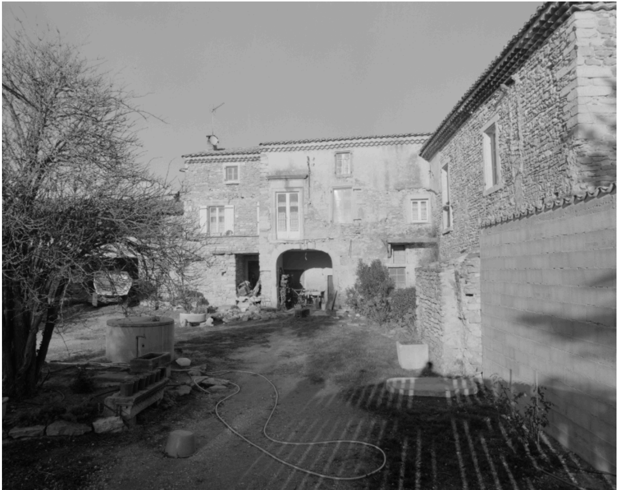
Beloure (C2 389). Vue d'ensemble du bâtiment depuis la cour.
