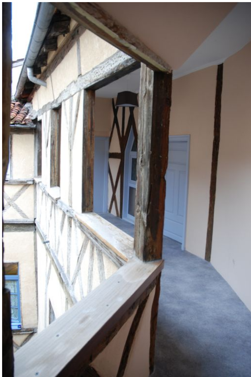
Vue de la galerie du 2e étage.
