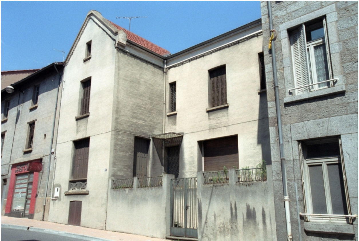
Boën, îlot 22, Lyon (rue de) 23. Vue générale de la façade sur cour.
