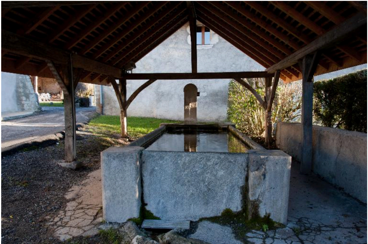
Vue du bassin sous son abri.
