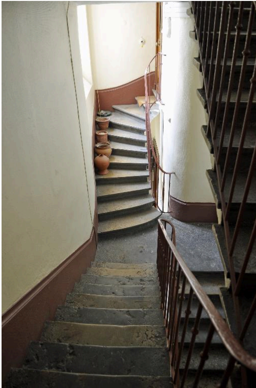
Vue intérieure de l'immeuble : escalier à trois volées divergentes
