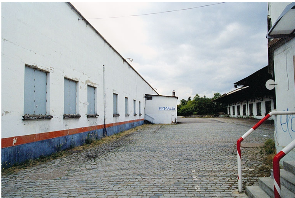
Ateliers vue nord : imprimerie et quais de chargement
