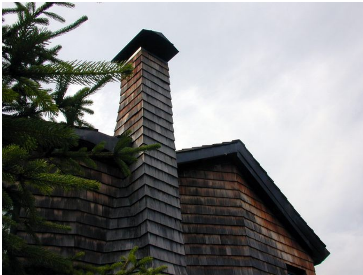
Détail de la cheminée
