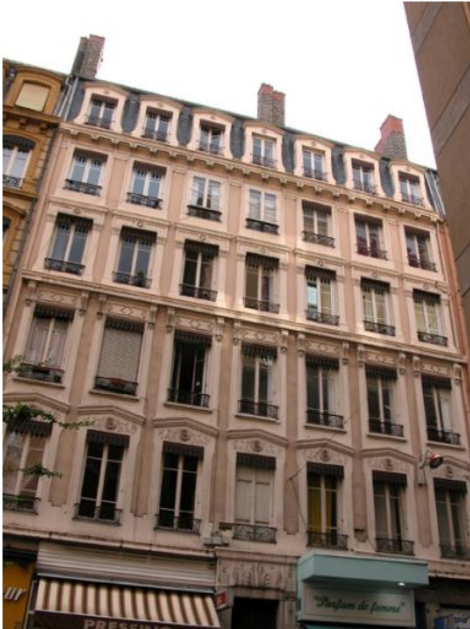
Façade, vue générale
