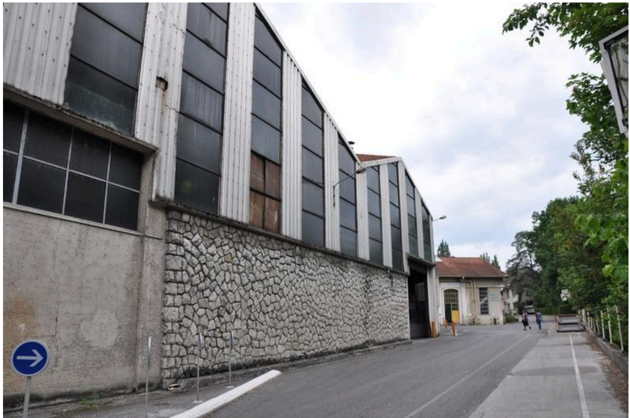
Voie intérieure de l'usine
