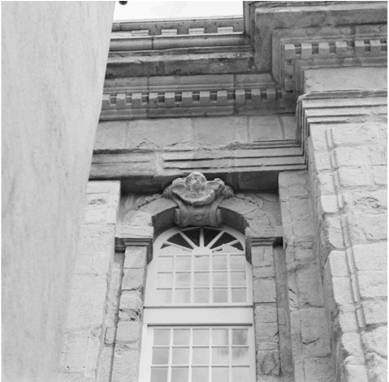
Façade, 2e niveau, baie latérale gauche, détail.
