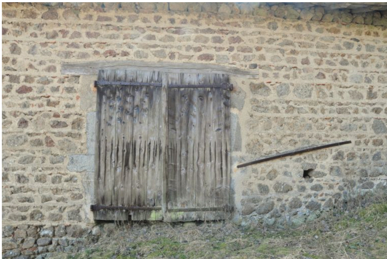
Vue d'ensemble de l'entrée de la grange sur le mur gouttereau nord.
