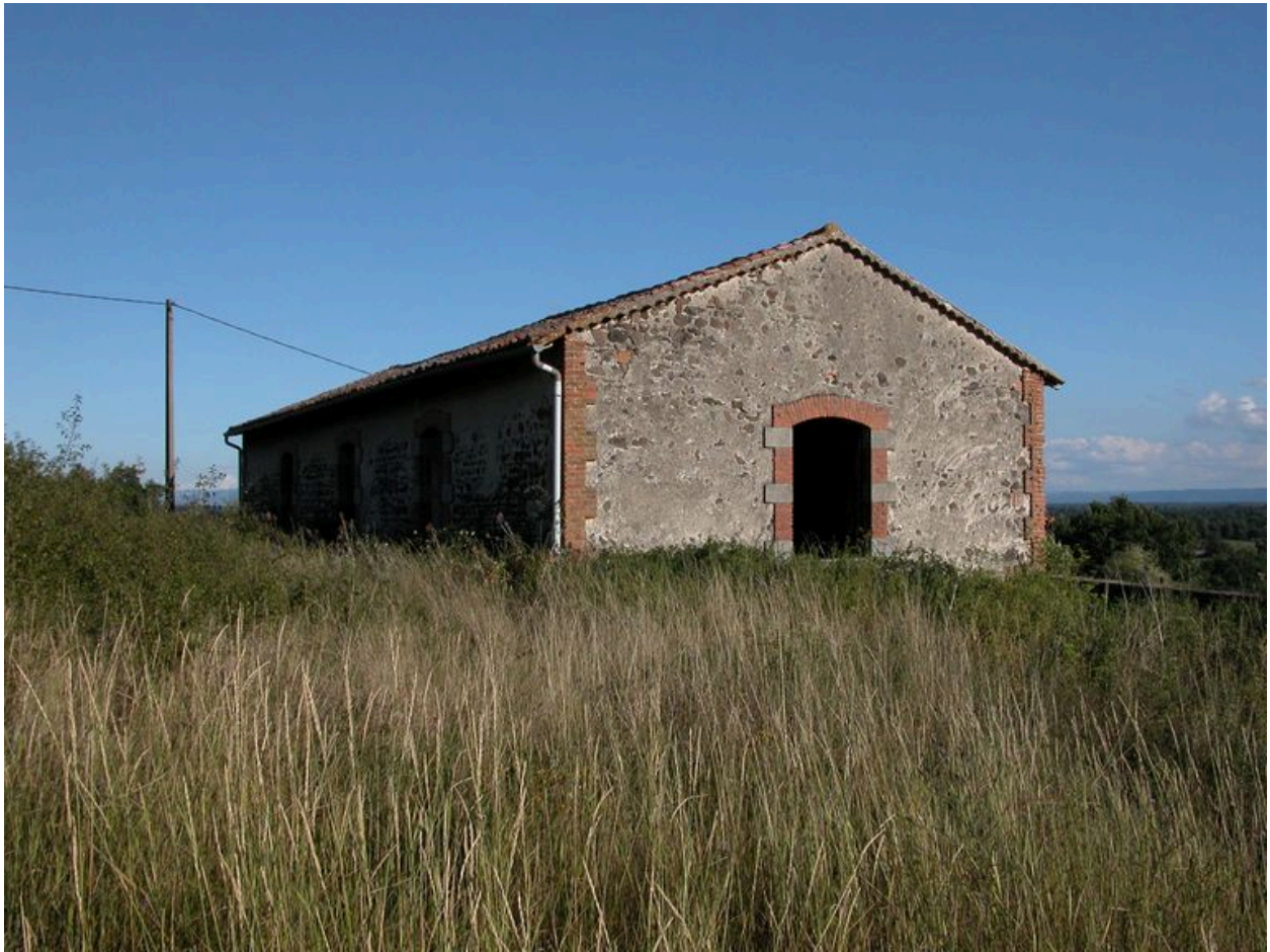
Vue d'ensemble du bâtiment principal depuis le nord-ouest.
