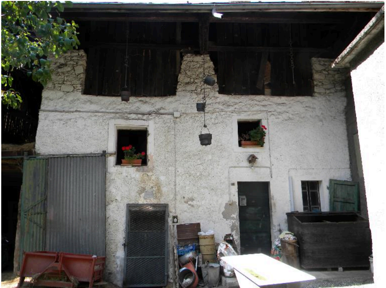
Vue de la façade principale d'une ancienne ferme (2008 F7 865)
