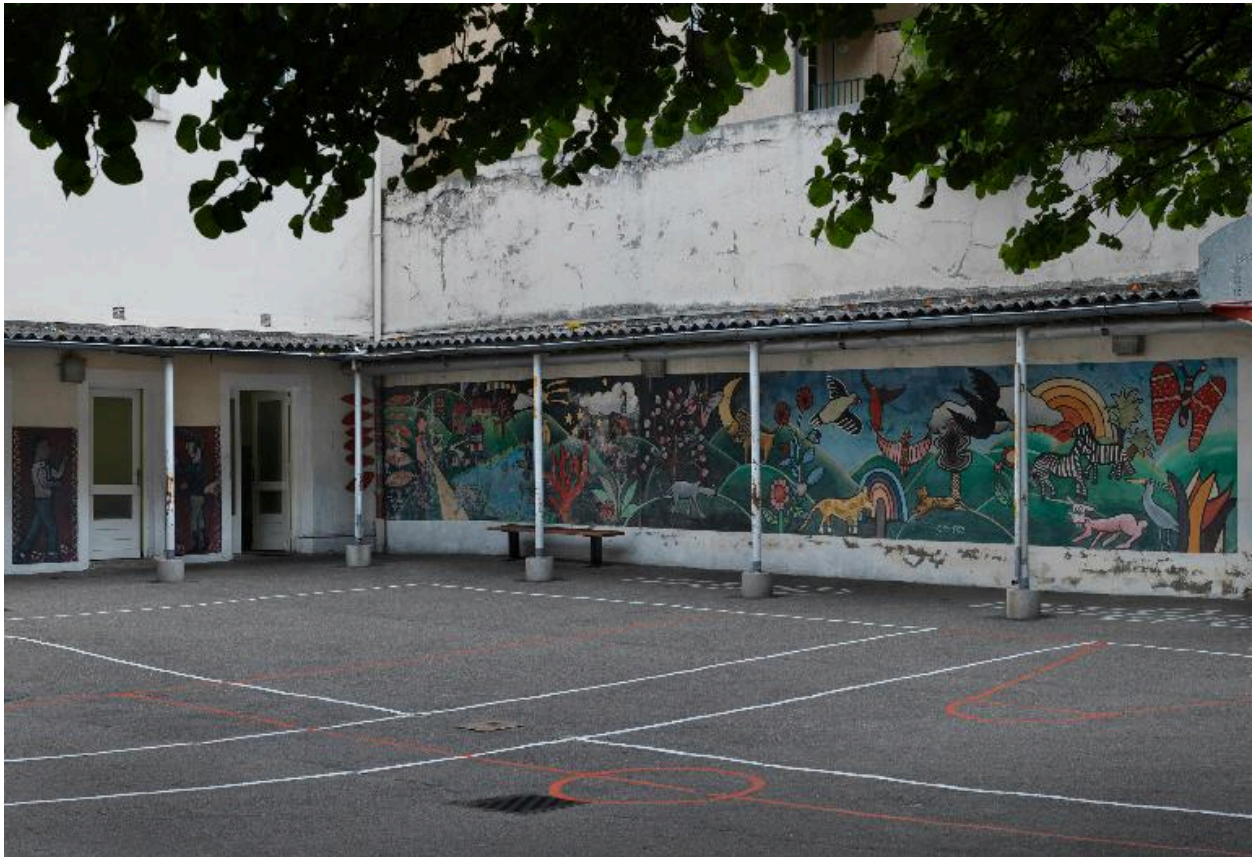
Vue du portique construit en 1975
