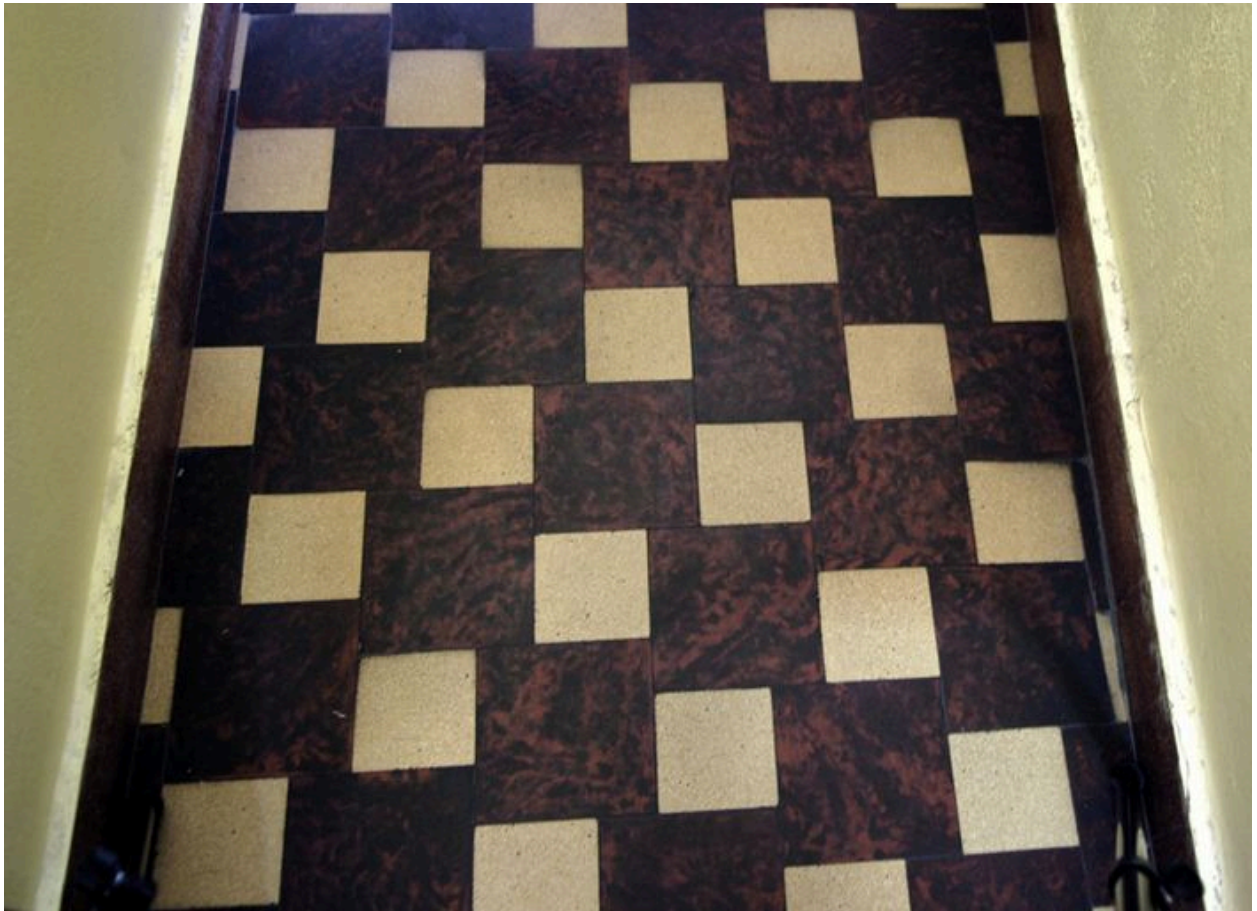
1er étage, carrelage des sanitaires.
