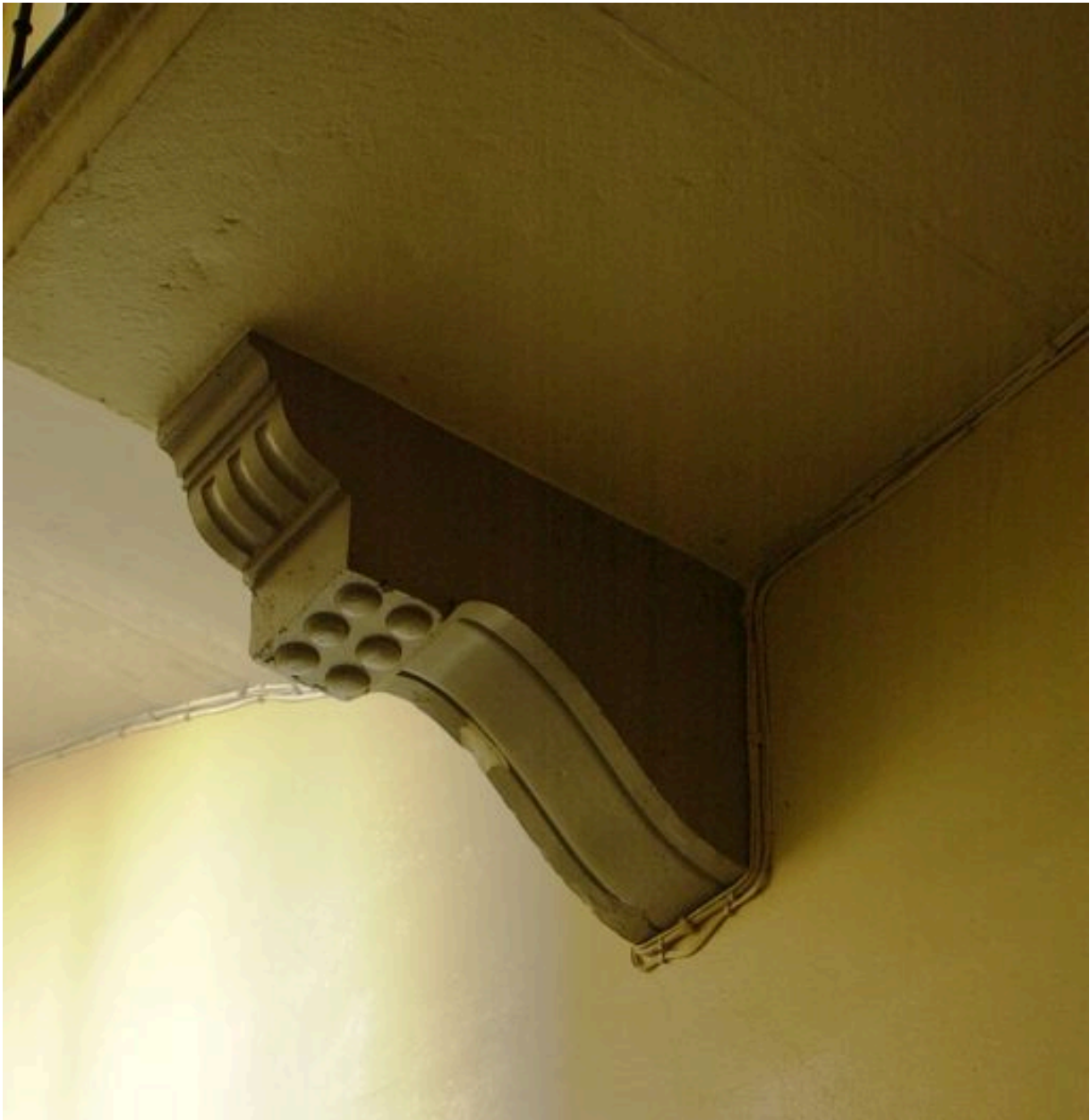
Détail d'une console moulurée soutenant le palier
