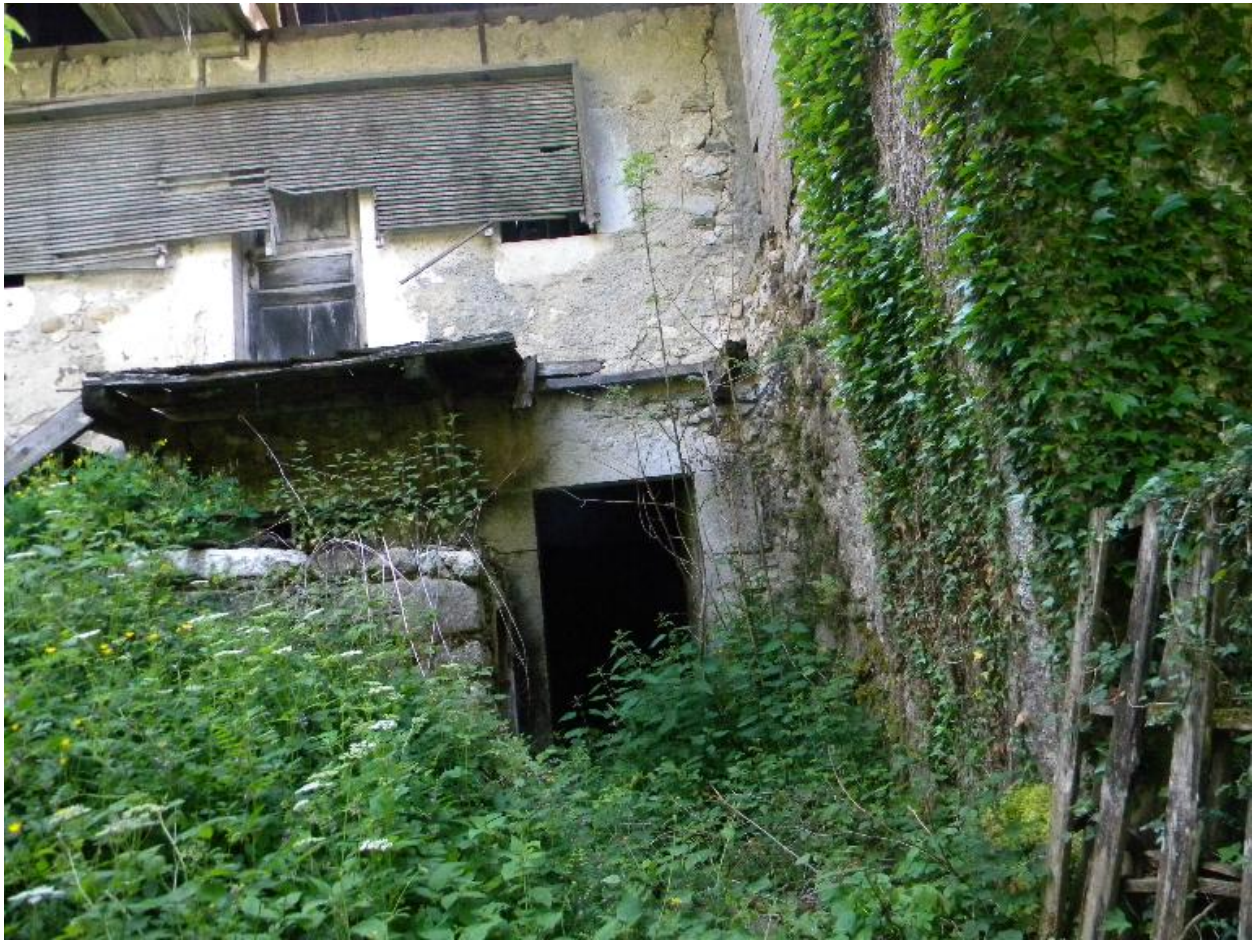
Vue de l'étage de soubassement en façade principale d'une ancienne maison (2008 B5 871).
