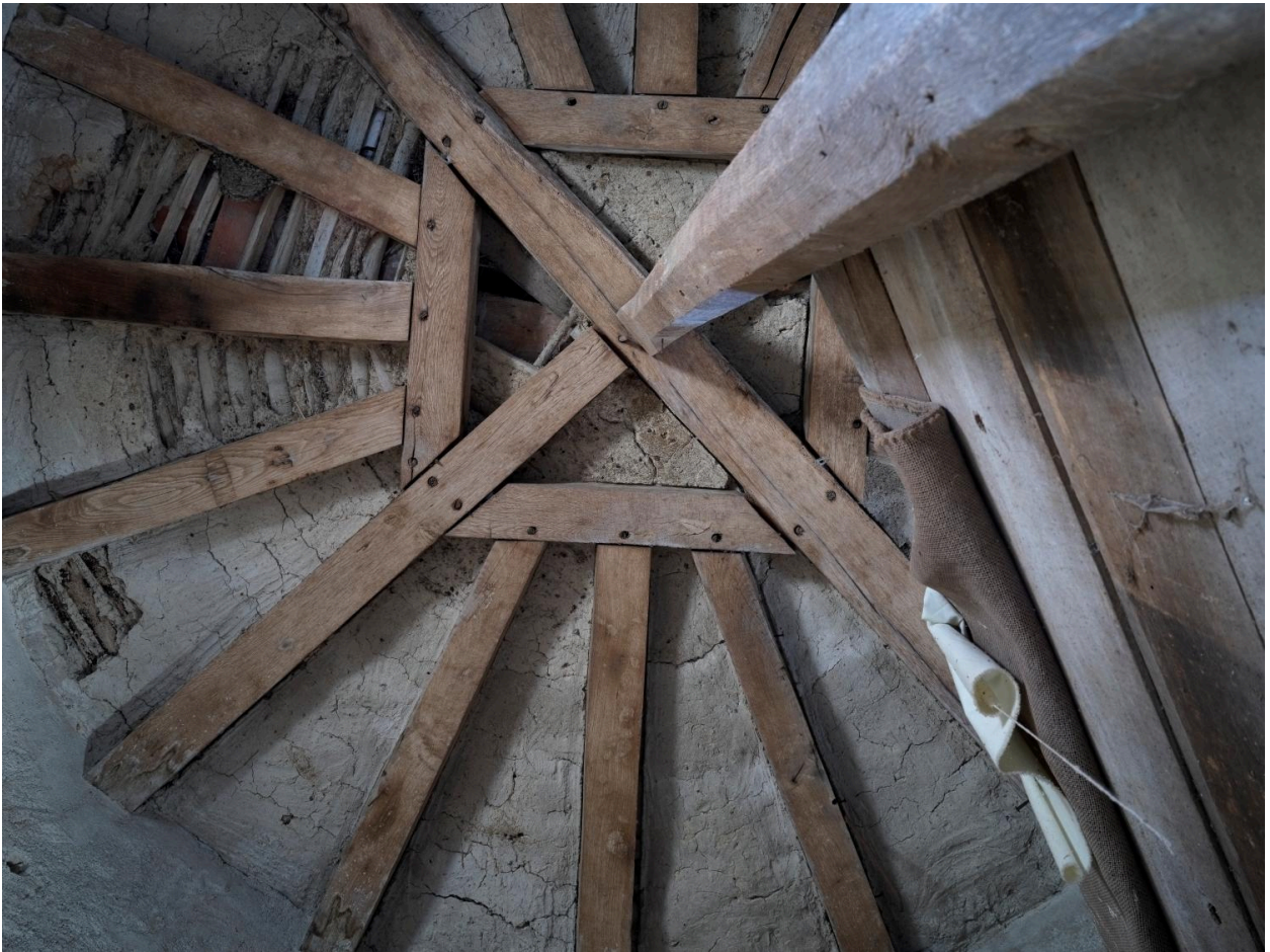
Détail de l'enrayure de la charpente conique au sommet de l'escalier.
