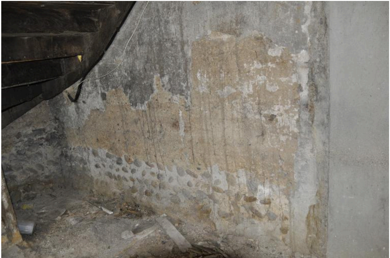
Vue sous l'escalier de la structure en pisé
