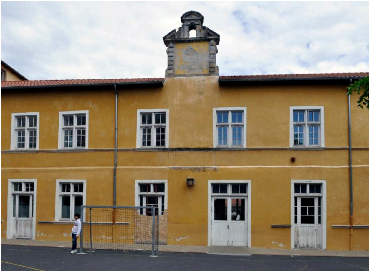
Bâtiment F: élévation sur cour 2, vue partielle
