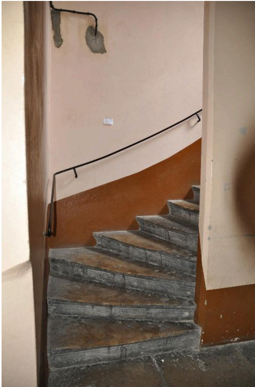
Vue du départ de l'escalier
