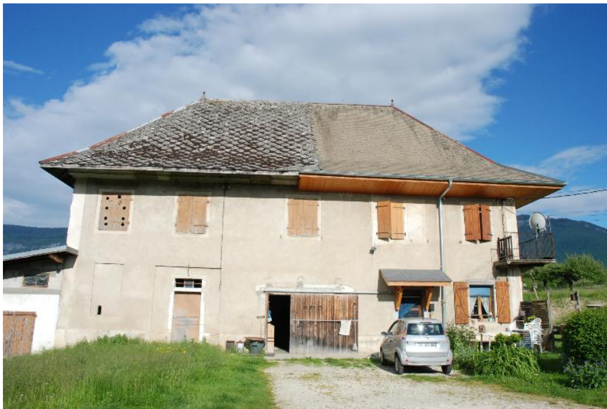
Bâtiment ouest, façade sur cour (façade ouest).
