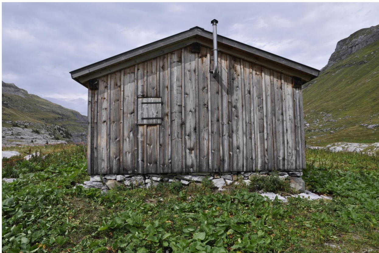
Vue du mur pignon sud
