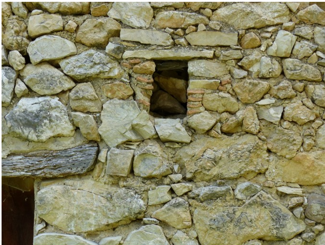
Pignon sud, deuxième niveau. Petit jour.
