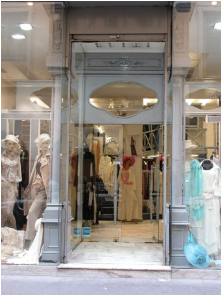
Boutique, vestiges du tambour d'entrée, vue depuis l'extérieur
