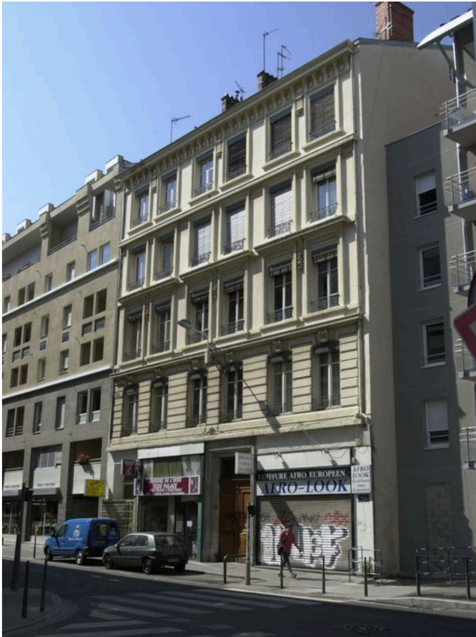
Vue générale de la façade
