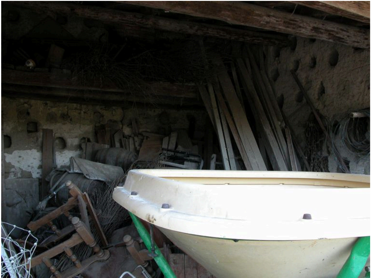
Vue intérieure du pigeonnier : on aperçoit les trous de boulin.
