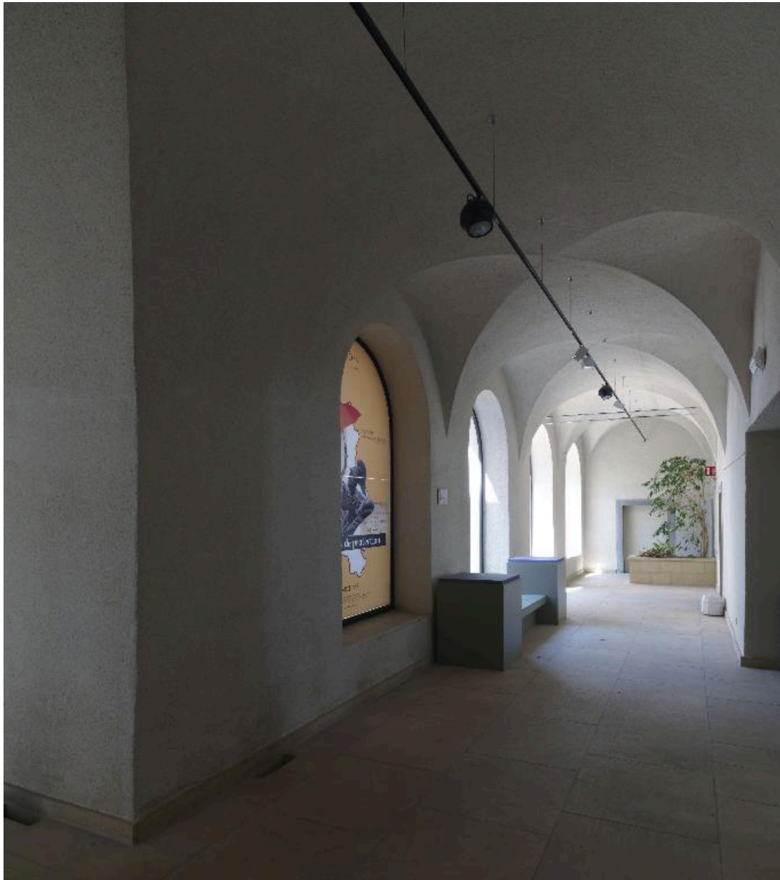
Vue de la galerie est du cloître
