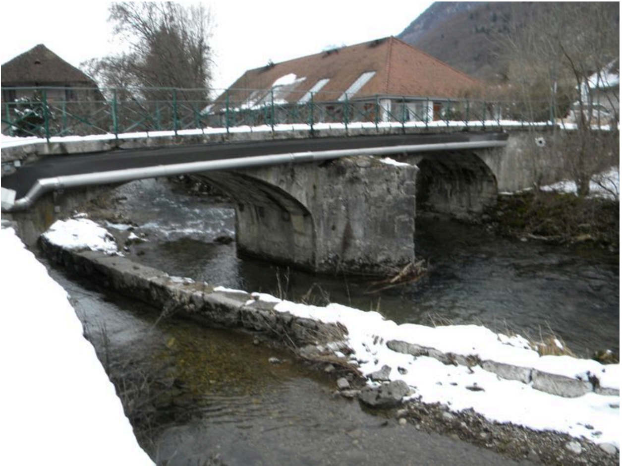
Vue générale depuis l'amont.
