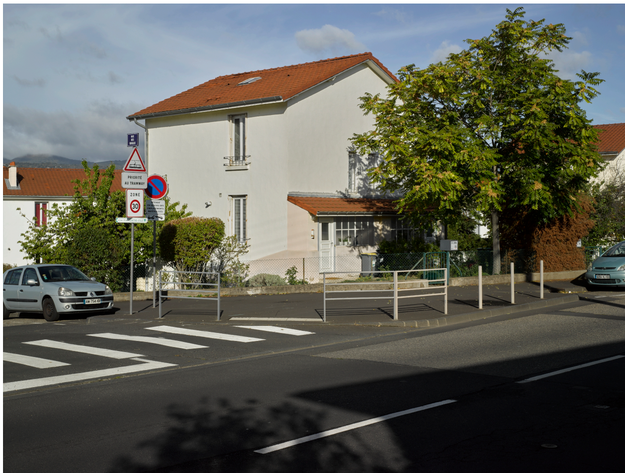
Maison double de type T des années 1920, à l'angle de la rue des Rivaux et de la rue des Meuniers (partie sud de la cité de Lachaux).
