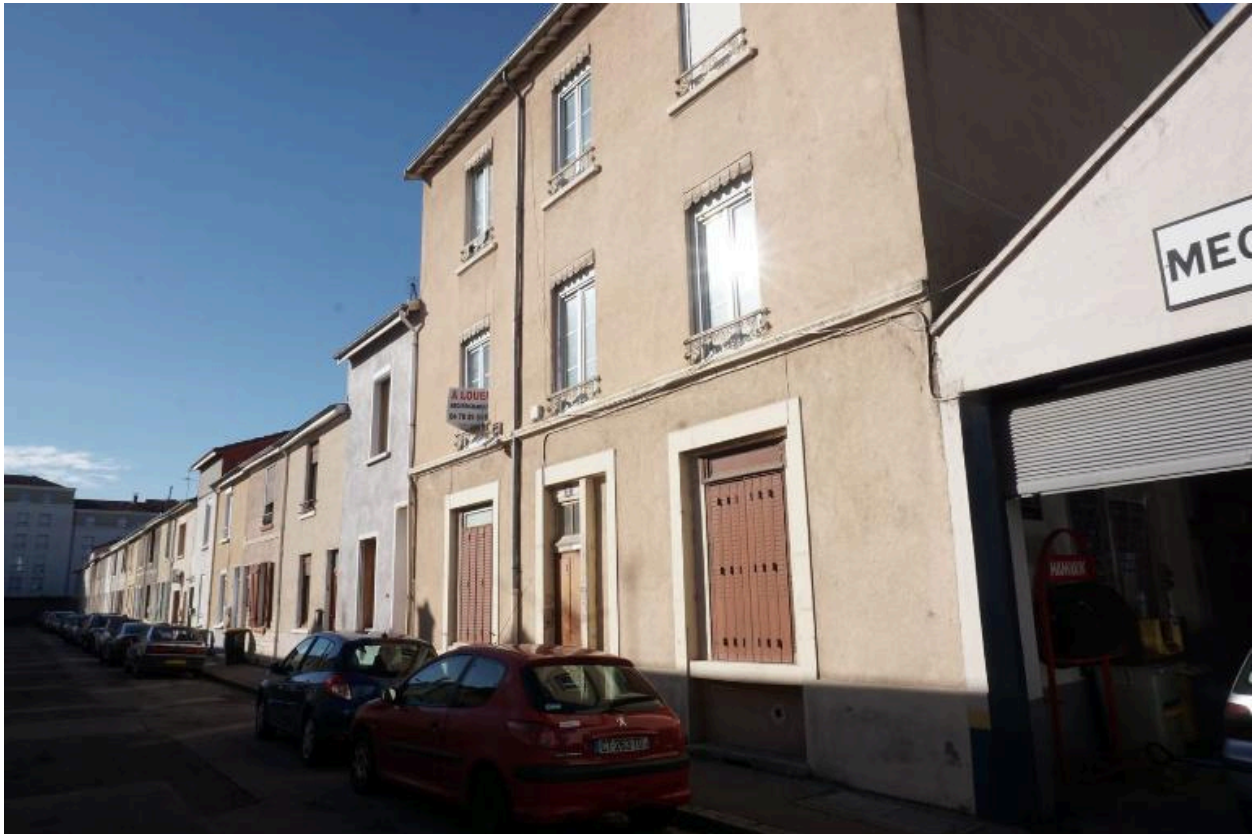
Détail nord-ouest depuis entrée rue Brachet
