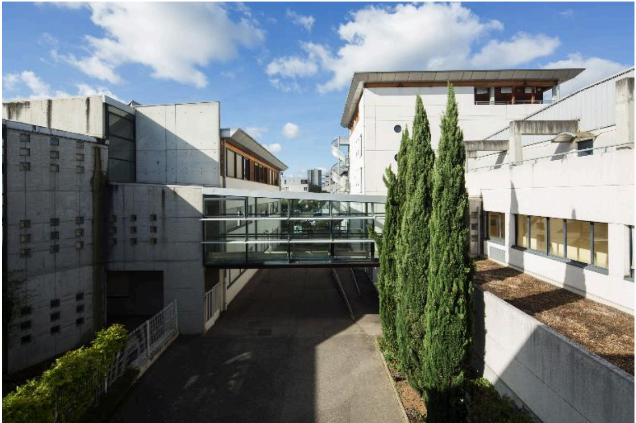
Passerelle H reliant les bâtiments C et D
