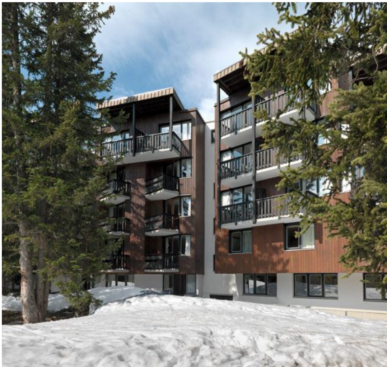
Elévation nord-est de l'hôtel Mercure. Articulation entre 2 corps de bâtiment
