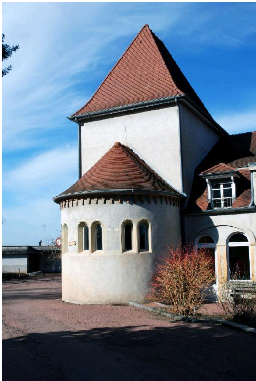
Pavillon angle sud-ouest et abside de l'ancien oratoire
