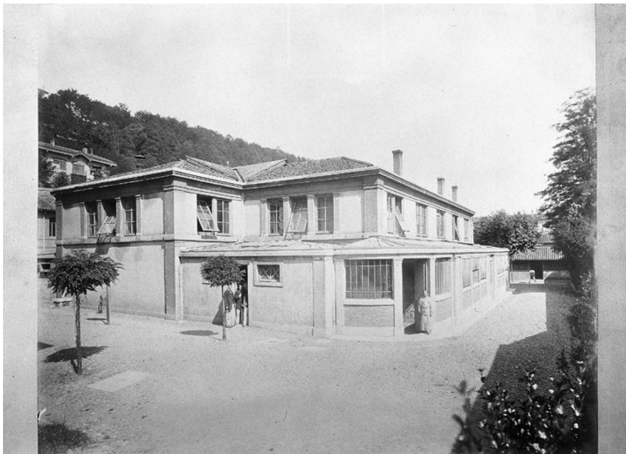
Bâtiment d'anatomie, angle sud-est
