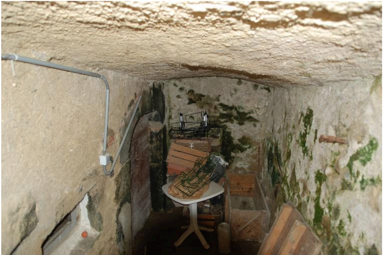
Vue d'ensemble de la porte de la cave, abritée sous une voûte plate.
