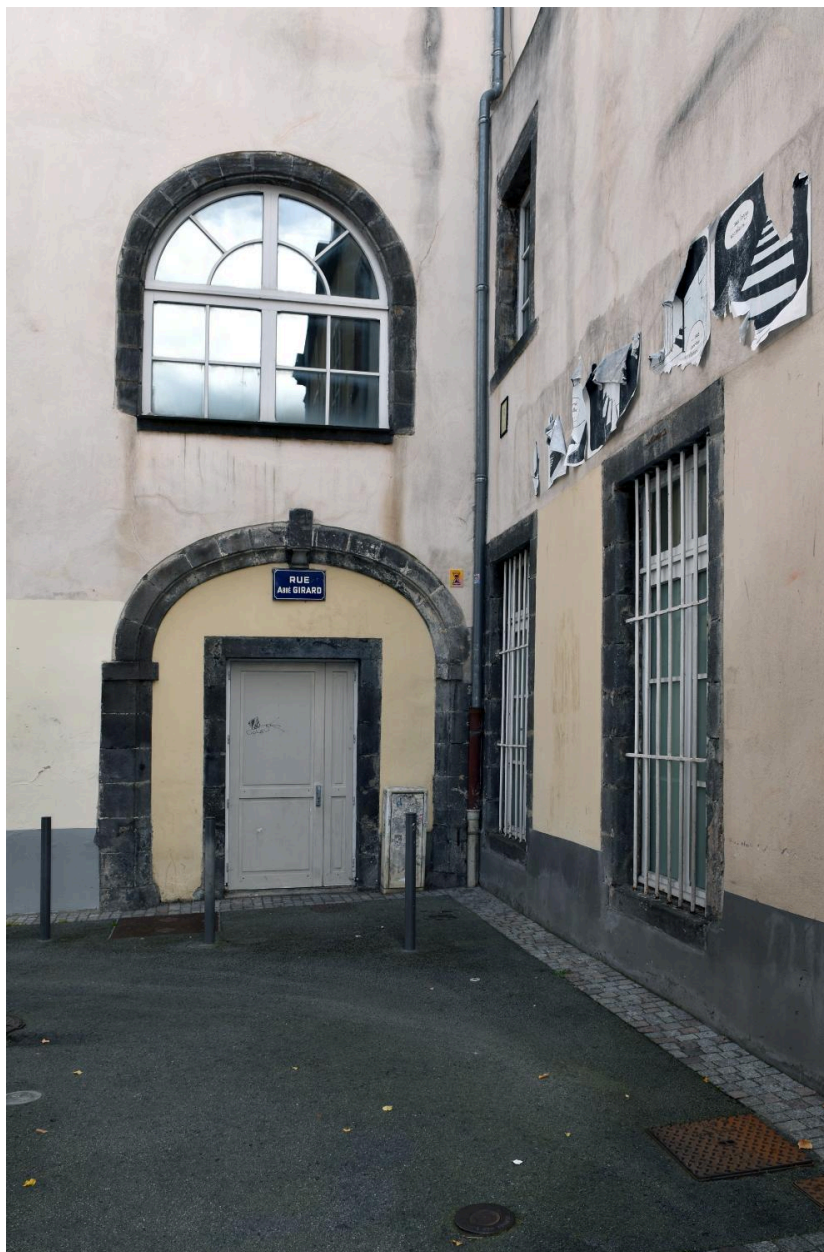
Elévation latérale ouest : ancienne entrée du collège, rue Abbé-Girard
