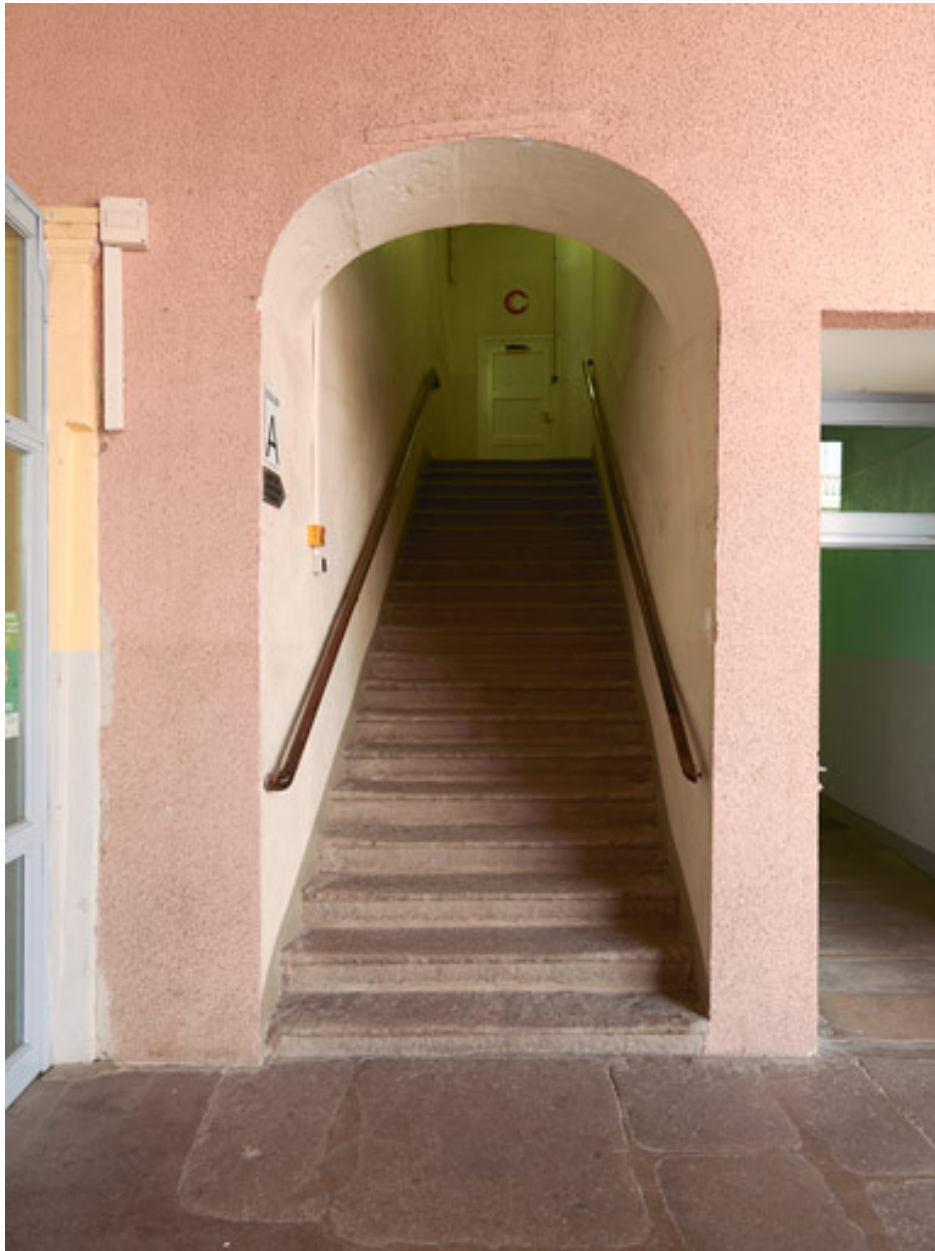
Bâtiment A : départ de l'escalier du 17e siècle.
