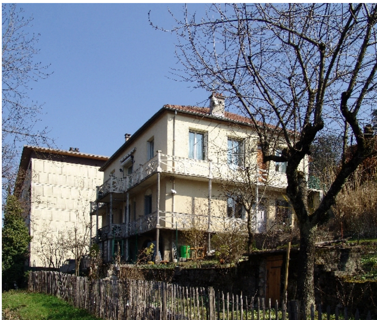
Vue du sud-ouest
