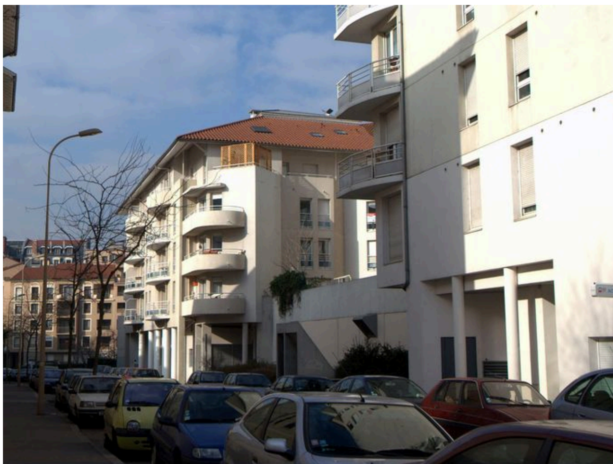
Elévation antérieure, vue partielle depuis l'est
