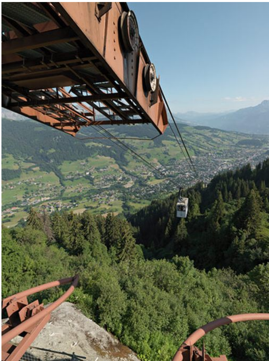
La passerelle de lancement de la gare supérieure et la cabine en descente
