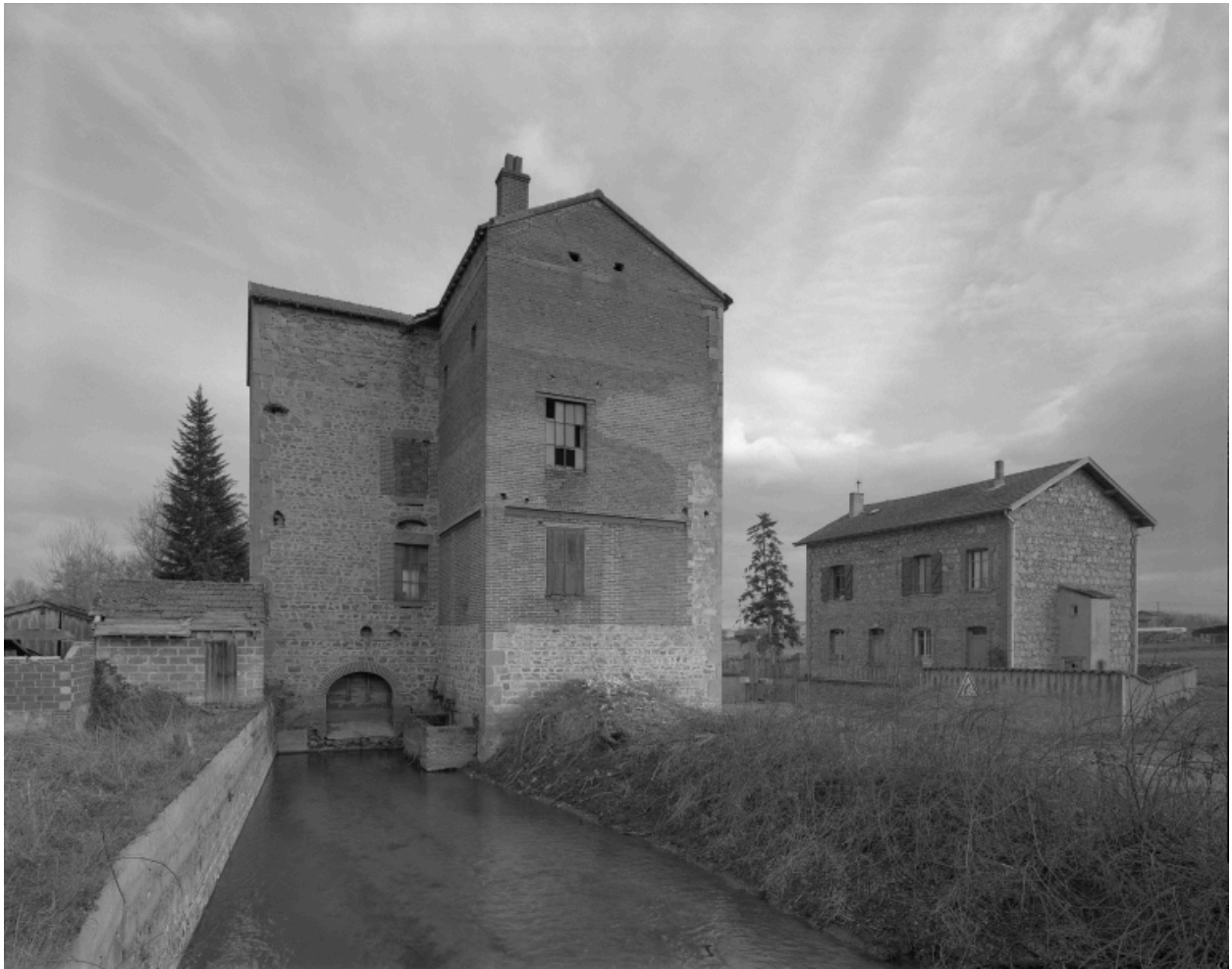
Vue d'ensemble de l'élévation ouest du moulin, avec l'arrivée du bief. Vue d'ensemble de la maison du meunier, sur la droite.
