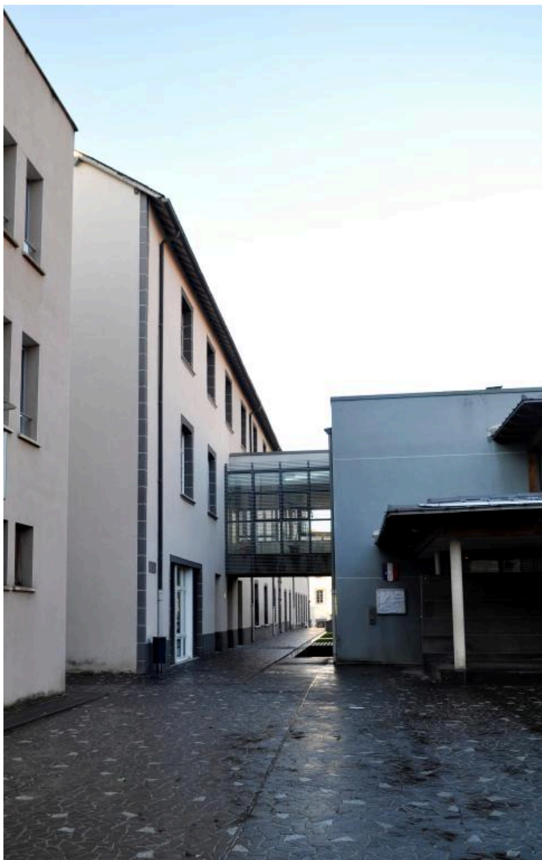
Corps de bâtiment ouest : vue d'ensemble depuis le sud (rue des Agials)
